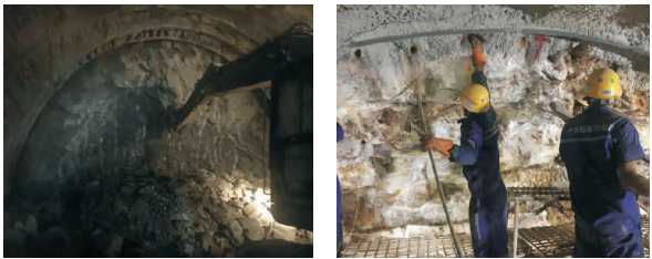
图 3 机械配合松动爆破现场施工照片
