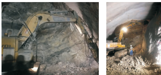
图 1 静态破碎机械开挖照片
