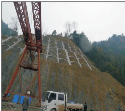
图2 边坡现场施工图
