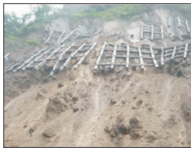
图 1 框架梁底破坏后梁体下滑
