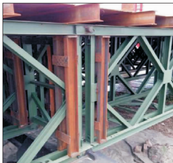
图 10 增设 2[10 槽钢现场示意图
