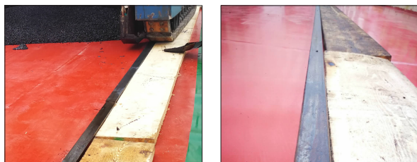
图5 木板轨道及边界限制侧模布置
