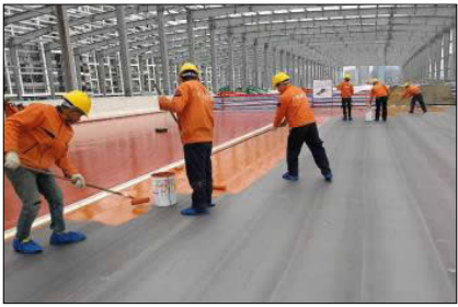
图 3 防腐底涂层施工
