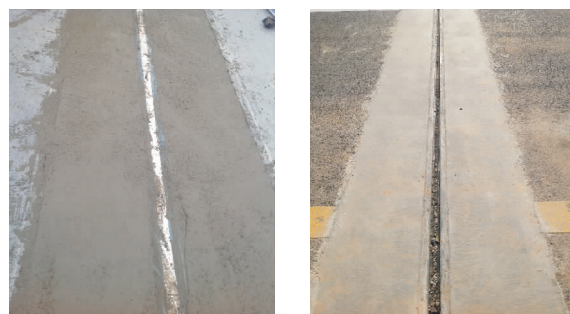
图5 公路桥梁伸缩缝高性能砗的应用
