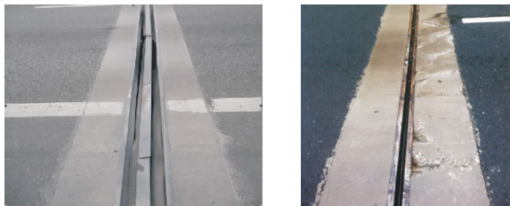
图 1 模数式伸缩缝损伤病害
