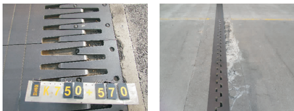
图 2 梳齿板式伸缩缝损伤病害
