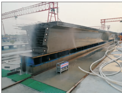
图 5 整体喷淋养护效果
