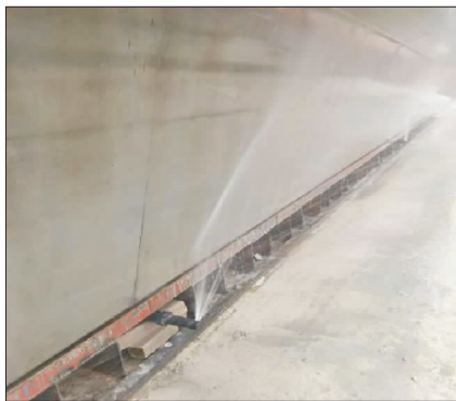
图 4 腹板喷淋养护效果
