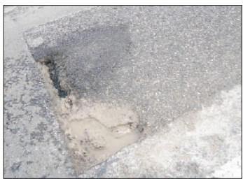
图2 溶剂型冷补料使用22周后效果
