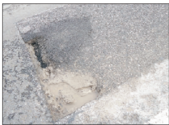
图2 溶剂型冷补料使用22周后效果
