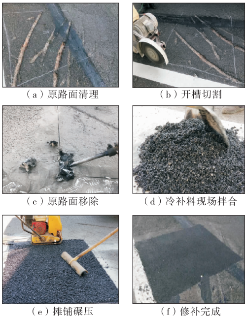
图 1 反应型冷补料主要修补步骤
