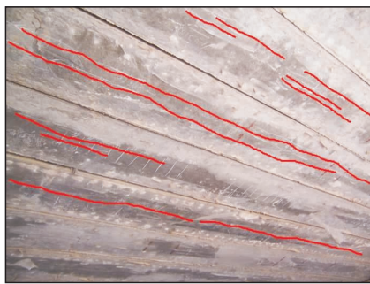
图 1 空心板梁底板纵向裂缝整体情况
