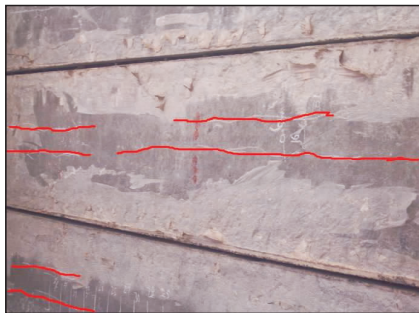
图 2 空心板梁底板纵向裂缝局部状况
