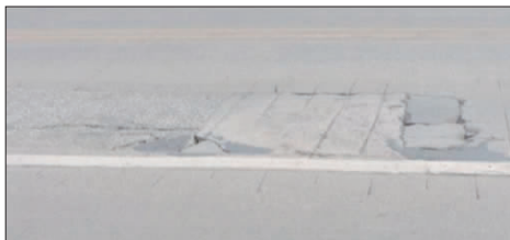
图9 铰缝处桥面裂缝及破损
