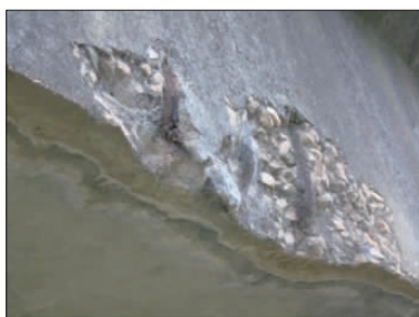
图 4 梁底破损露筋
