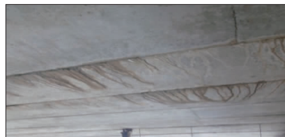
图 8 板梁与铰缝界面处渗水
