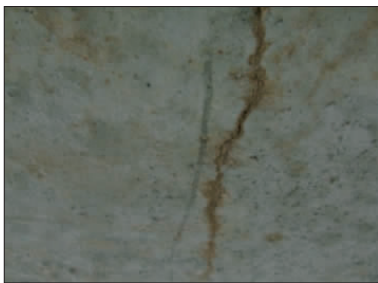
图 5 主梁空心板纵向裂缝
