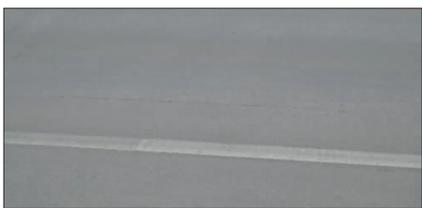
图10 铰缝处桥面裂缝
