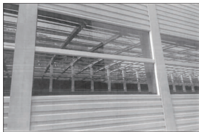
图4 15 mm厚加筋防撞亚克力板
