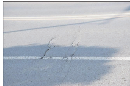
图 8 桥面破损
