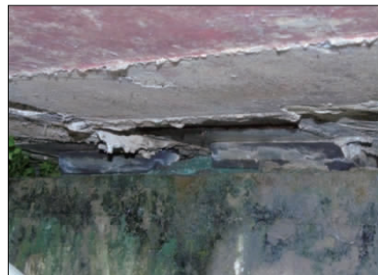
图5 支座剪切变形
