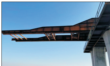
图 5 导梁结构
