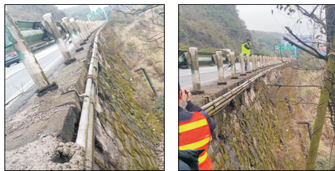
图 1 沪昆高速公路贵新段原挡墙上部护栏防护设施
