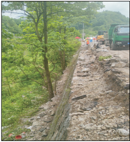
图 3 拆除原护栏后挡墙顶面状况
