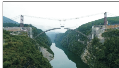
图 2 渔塘特大桥缆索吊机工作照片
