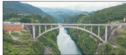
图 1 渔塘特大桥建成照片
