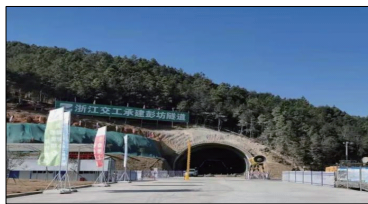
图 1 彭坊隧道左洞施工现场
